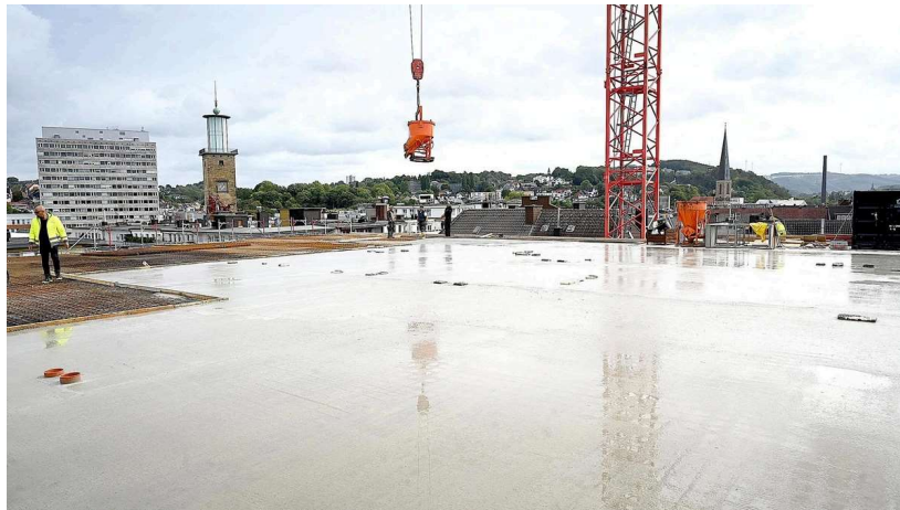
Auf dem Dach werden aktuell die Betondecken gegossen.
